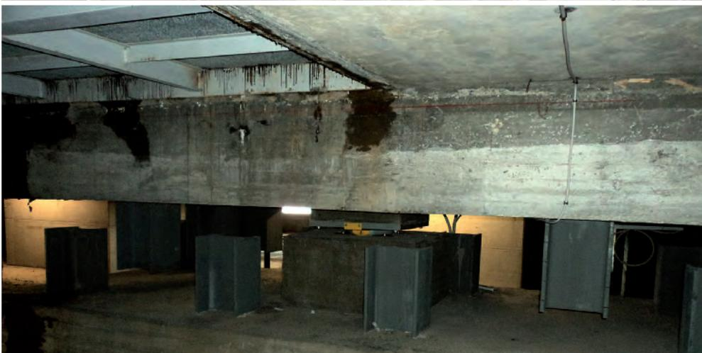
**LA TORRE EUROSKY** è protetta nella sua struttura dal rischio sismico tramite una serie di dissipatori collocato tra l'ultimo solaio delle abitazioni e il primo del volume degli impianti.
