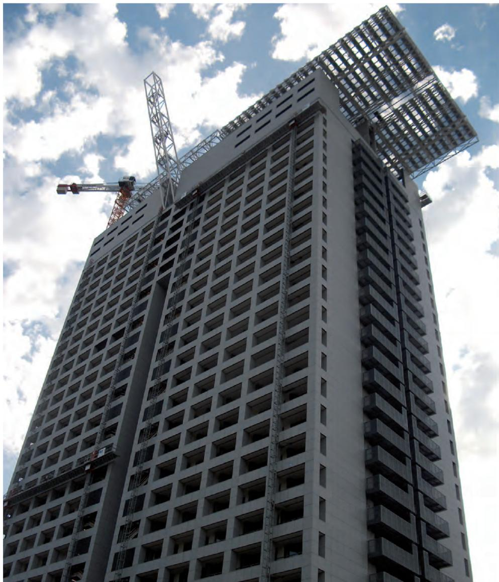
**FACCIATA DELLA TORRE** residenziale in fase di ultimazione. Sia le travi di parapetto che i pilastri sono strutture false, appositamente realizzate con moduli prefabbricati di facciata continua a cellule in alluminio-granito.
