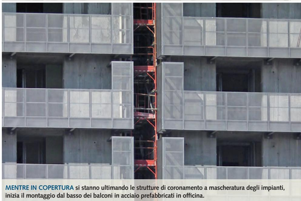
**MENTRE IN COPERTURA** si stanno ultimando le strutture di coronamento a mascheratura degli impianti, inizia il montaggio dal basso dei balconi in acciaio prefabbricati in officina.
