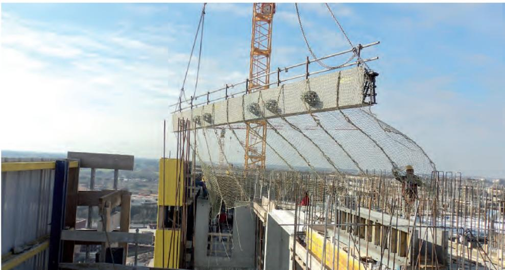
**LE TRAVI DI PIANO** sono tipo Rep realizzate con elementi prefabbricati autoportanti con piatto inferiore e corrente superiore in acciaio e un'anima di collegamento ottenuta con barre inclinate sempre in acciaio saldate.
