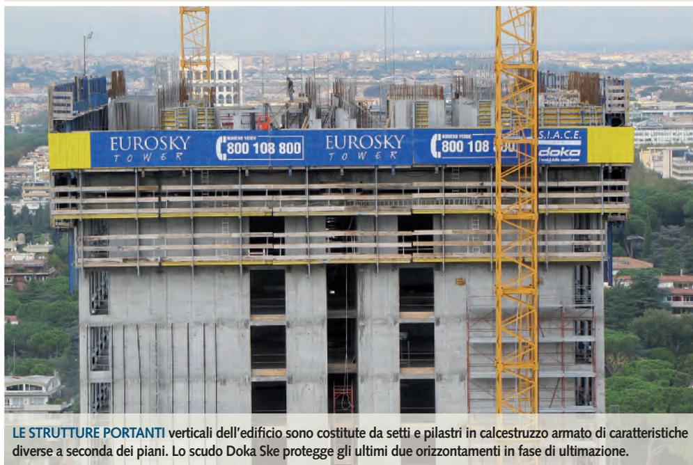
LE STRUTTURE PORTANTI verticali dell'edificio sono costituite da setti e pilastri in calcestruzzo armato di caratteristiche diverse a seconda dei piani. Lo scudo Doka Ske protegge gli ultimi due orizzontamenti in fase di ultimazione.
